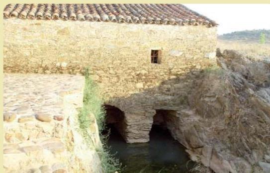
**Medidas** **Alto** 4 m **Ancho** 3,8 m **Largo** 11 m **M<sup>2</sup>** 41,8**Nº de paradas** DOS**Materiales tejados y bóvedas** Mampostería de piedras del lugar. Cubierta a un agua con teja árabe.**Observaciones** Entradas en rampa y salidas dos adinteladas. En el interior conserva una de las paradas en funcionamiento.
