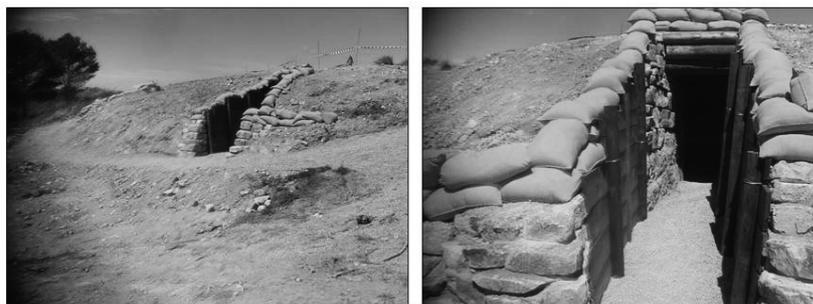
La protección antiaérea exige un gran espesor en cubierta
