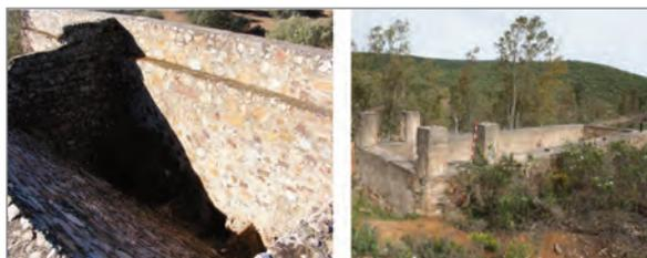
Figuras 34 y 35. Infraestructuras para el cable aéreo, tolva de carga y zona de recepción.
